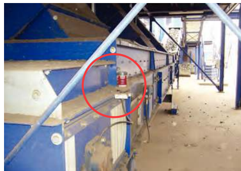
Lubrification du palier de pivotement d'un convoyeur
