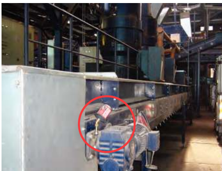
Lubrification du palier de pivotement d'un convoyeur
