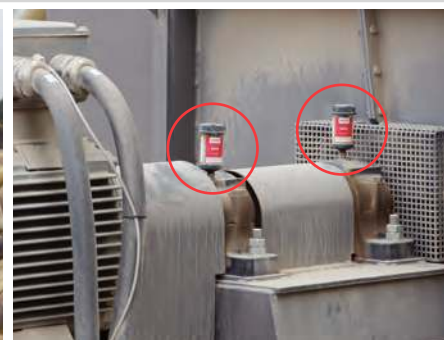
Lubrification du palier
