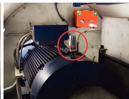
Lubrification des paliers de générateur
