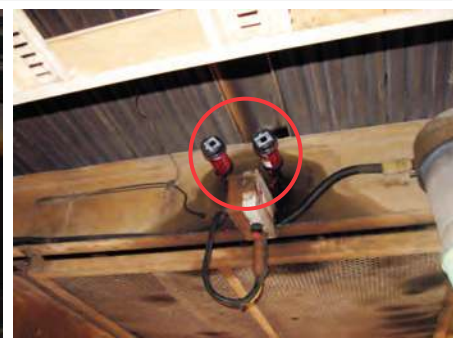
Lubrification du ventilateur (Fin Fan) d'une installation d'échangeur thermique
