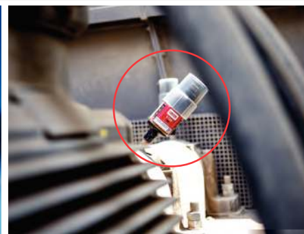
Lubrification de palier d'un dispositif de ventilation
