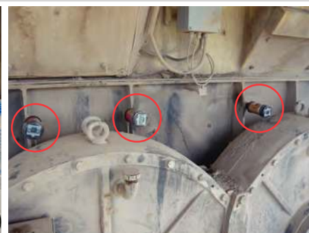
Lubrification d'un convoyeur
