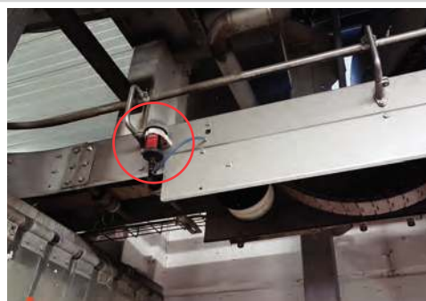
Lubrification de chaîne sur le transport de caisses vers l'éjecteur de caisses
