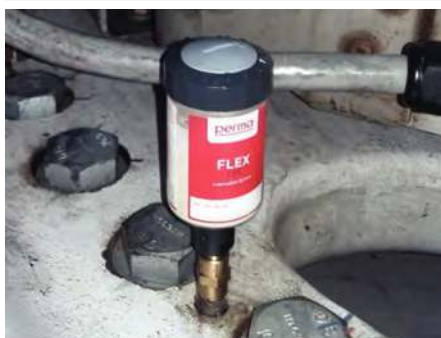
Lubrification de la couronne d'orientation
