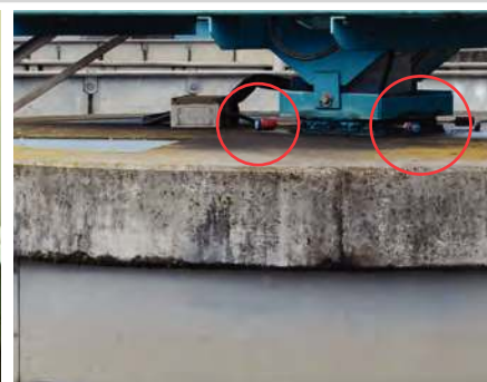
Lubrification du palier de pivotement sur un racleur circulaire
