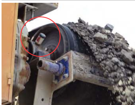
Lubrification du palier fonte d'un convoyeur
